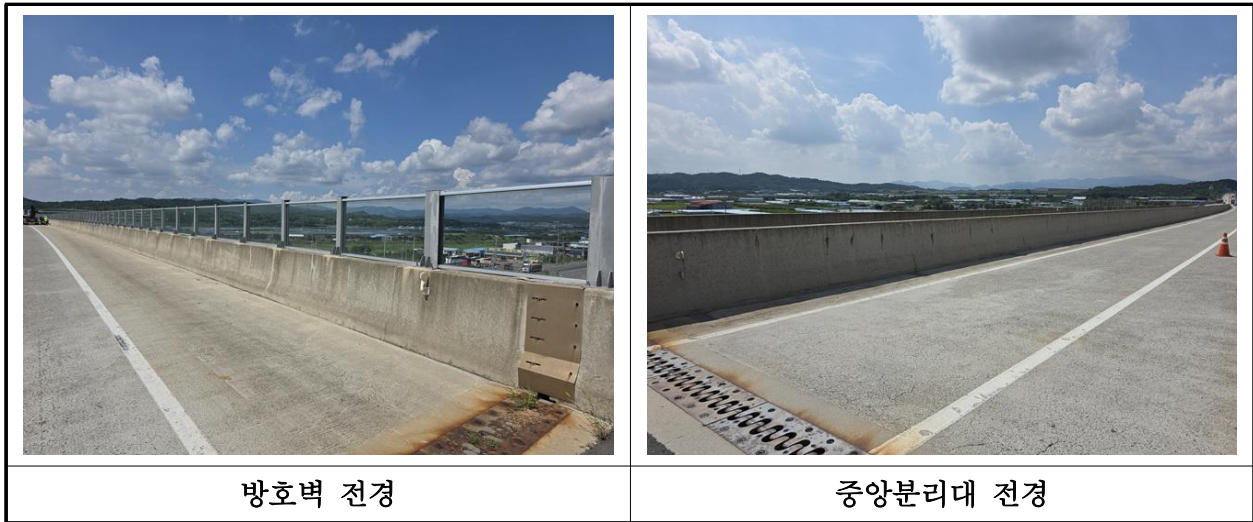
【사진 33.3.24】 방호벽 및 중앙분리대 전경
