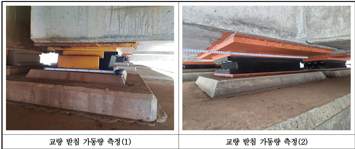
【사진 33.3.16】 교량받침 이동량 측정
