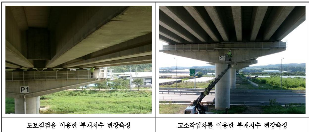
【사진 33.2.1】 부재 현장측정 전경
