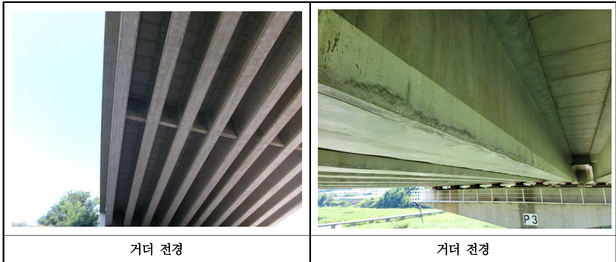
【사진 33.3.4】 거더 전경
