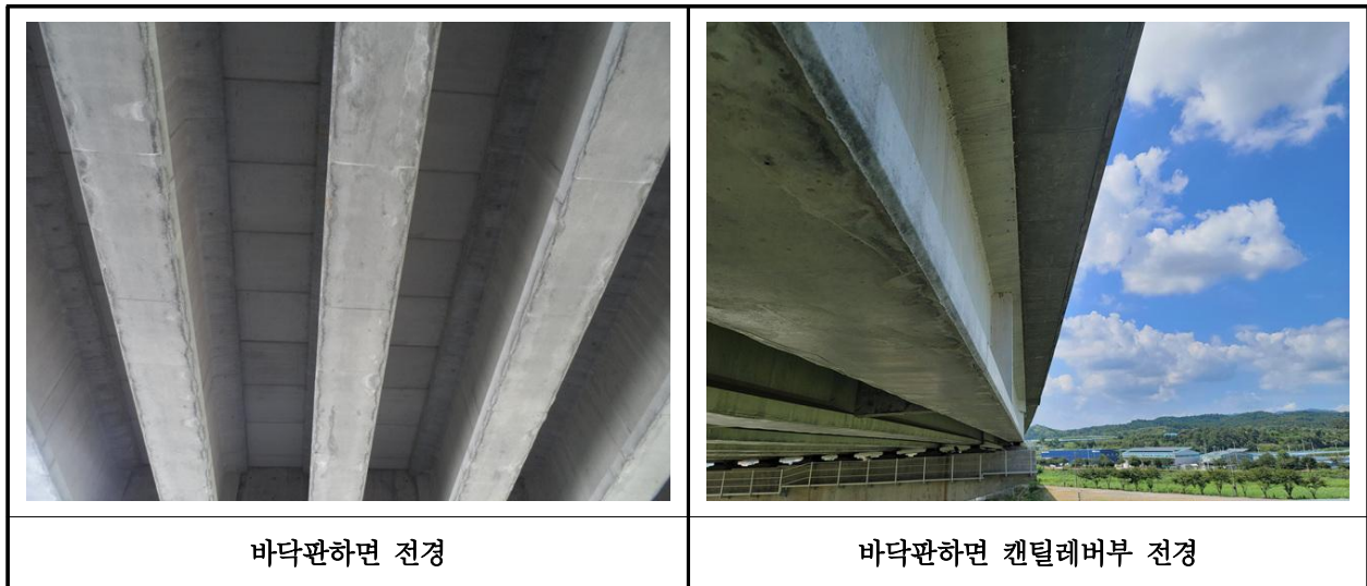
【사진 33.3.2】 바닥판하면 전경
