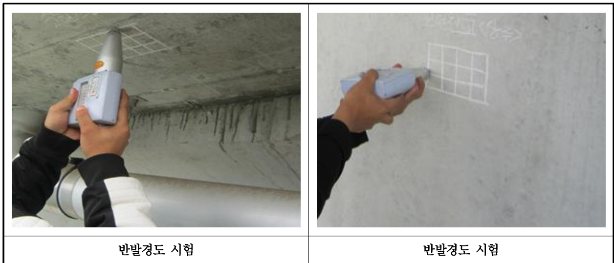
【사진 33.4.2】 반발경도시험 현장사진
