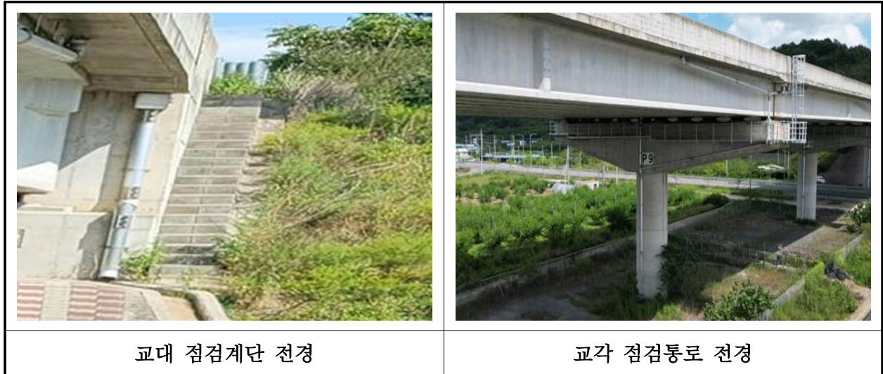
【사진 33.3.26】 교량 점검시설 전경
