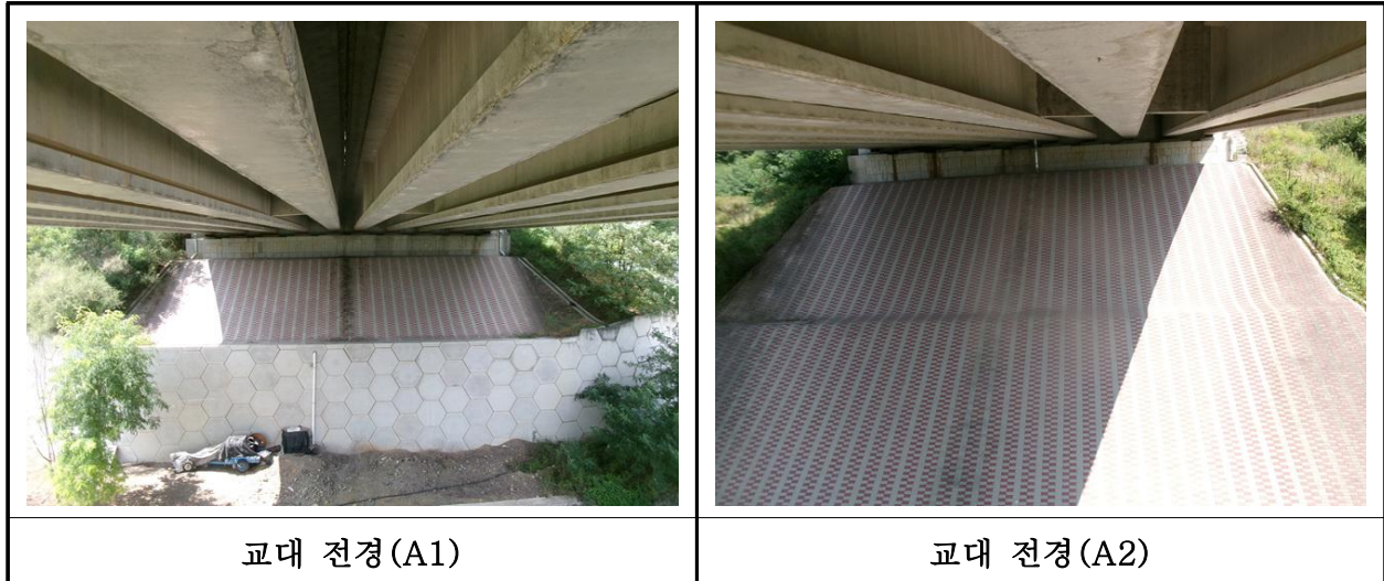
【사진 33.3.8】 교대 전경
