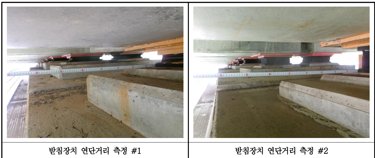
【사진 33.3.15】 교량받침장치 연단거리측정
