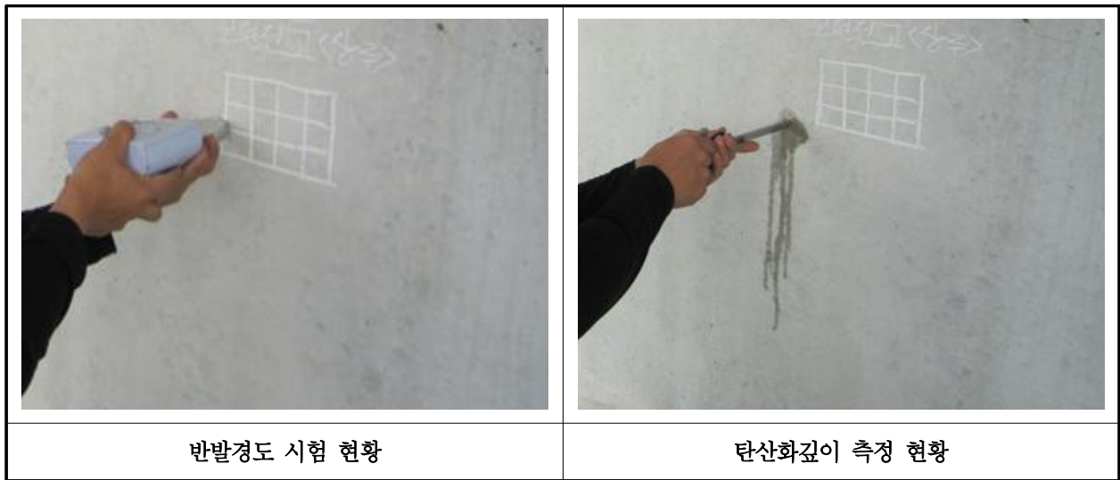
【사진 33.4.1】 콘크리트 내구성조사 현황
