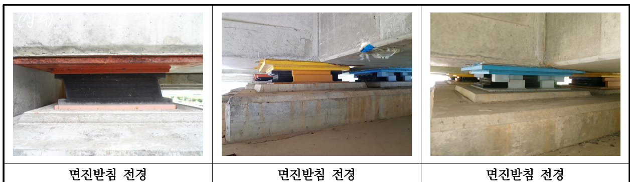
【사진 33.3.13】 교량받침 전경
